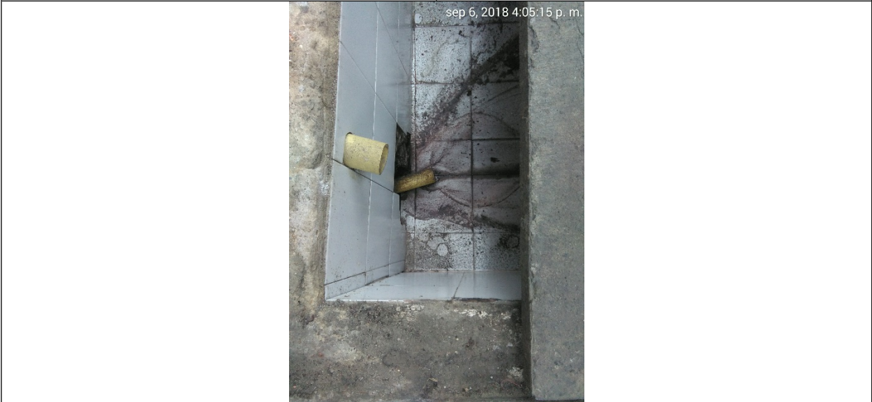
Foto No. 5 Punto de vertimiento de ARnD KR 19 A
